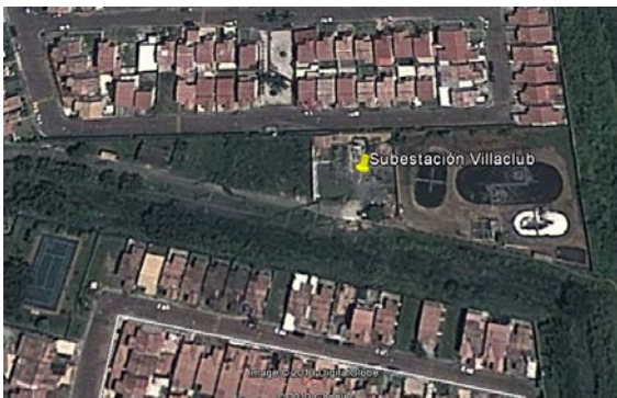
Figura 1. Vista satelital de la ubicación de la Subestación Villa Club
