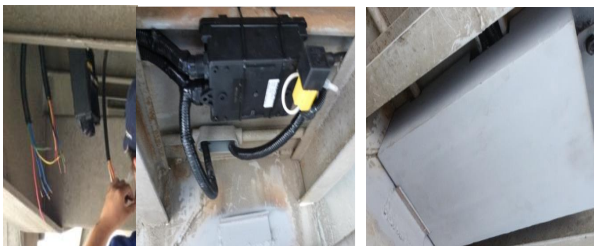
Fuente y elaboración: Los Autores Figura 4. 9 Instalación Powerbox
