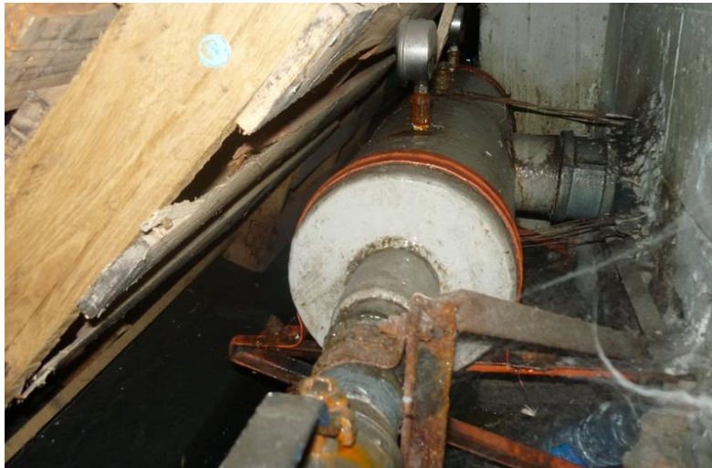
FIGURA 2.1 MANIFOLD DE DISTRIBUCIÓN PRINCIPAL.
