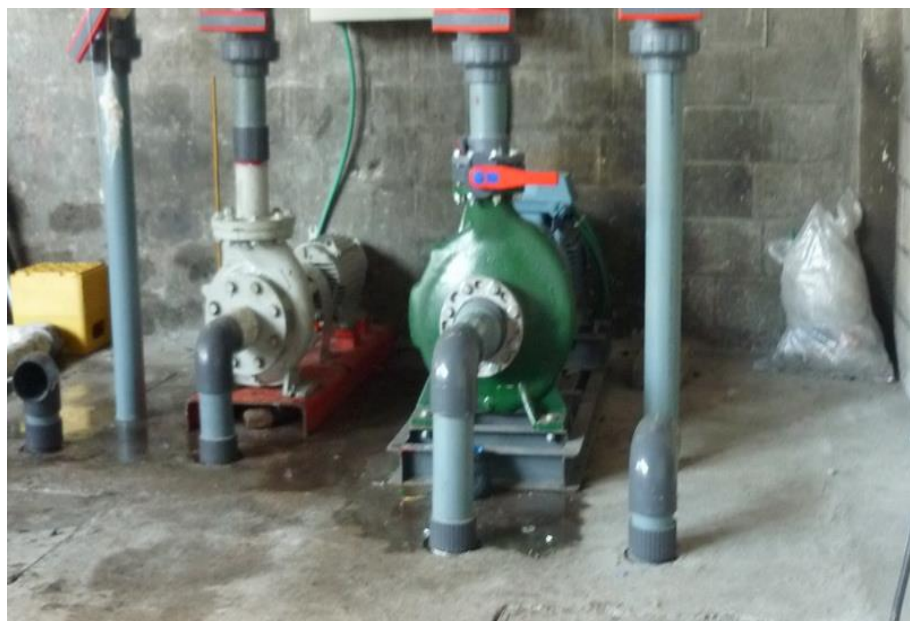
FIGURA 1.3 SISTEMA DE BOMBEO ACTUAL
