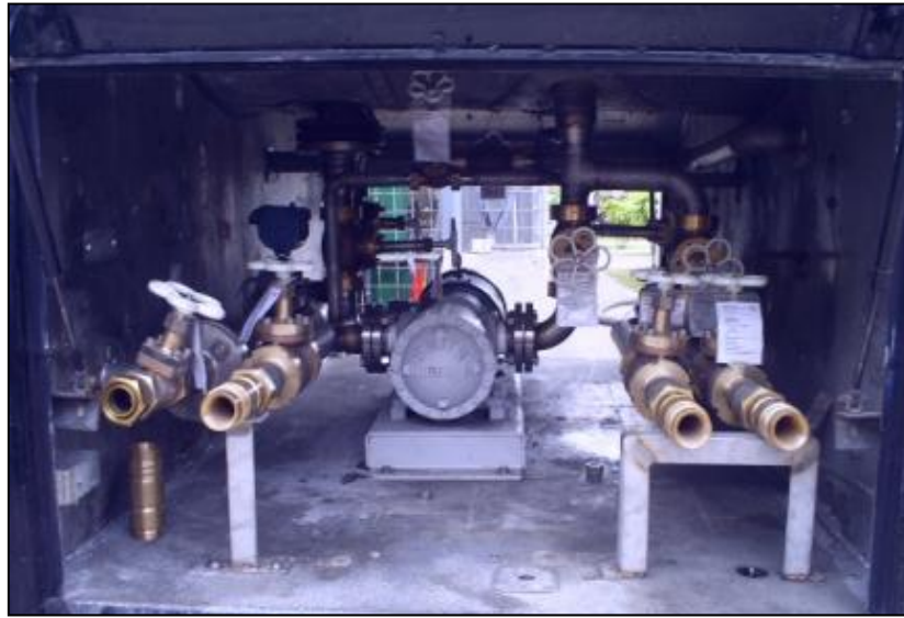
Figura 3.5. Instalación de las tomas de llenado y descarga
