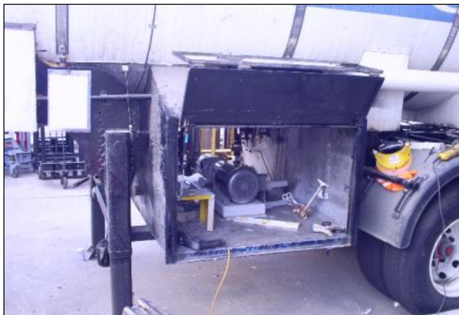
Figura 3.1. Instalación de la nueva Bomba Smith MC-3
