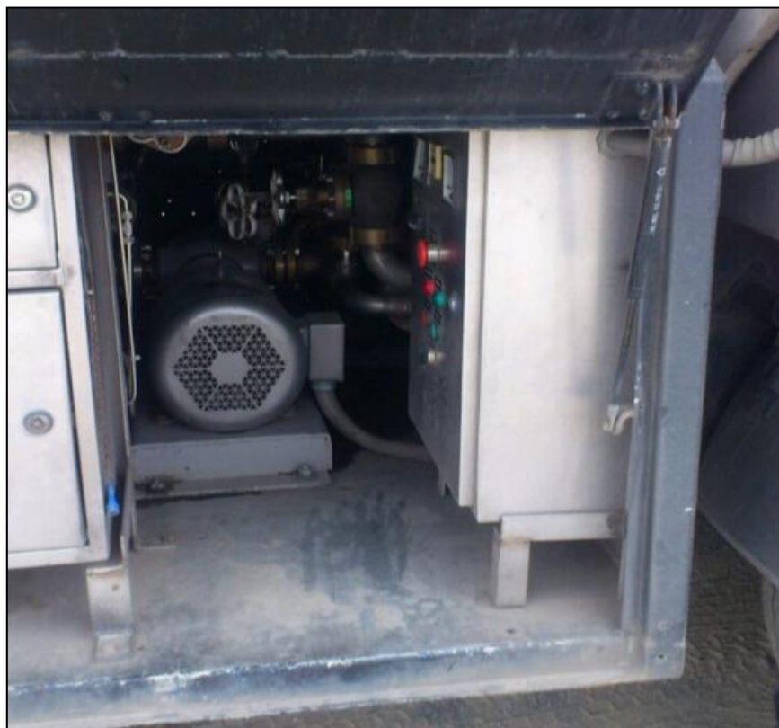
Figura 3.12. Vista del panel eléctrico nuevo, a la izquierda panel de análisis de calidad del producto
