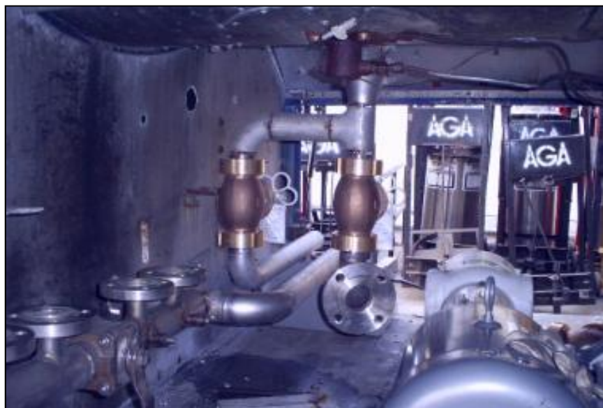
Figura 3.3. Vista de la instalación de las válvulas V2 y V4
