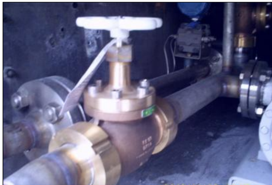
Figura 3.9. Vista de la válvula de globo Herose seleccionada
