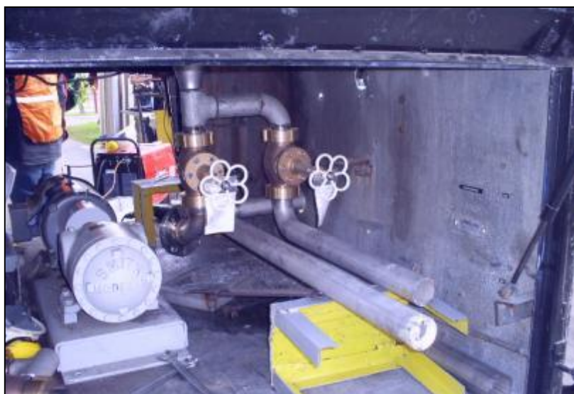
Figura 3.4. Instalación de las tuberías de descarga
