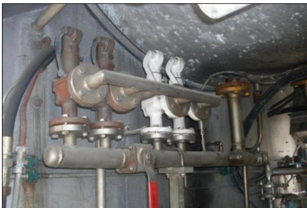
Figura 2.16. Arreglo de válvulas de seguridad existente
