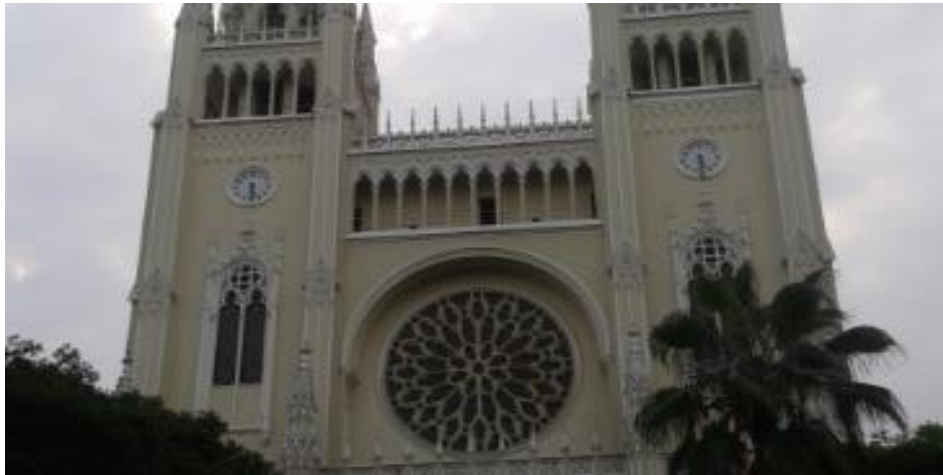
Ilustración 15 Rosetón de la fachada Catedral Metropolitana San Pedro Apóstol
