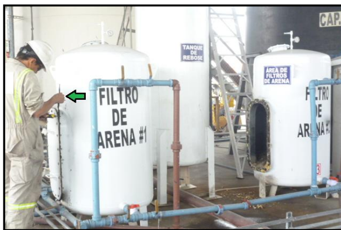
FIGURA 3.11 TAREAS REALIZADAS EN PTAR
