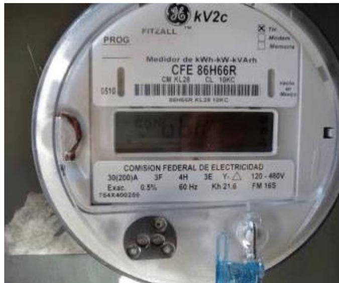
**Figura 2. 10 Medidor bidireccional [13]**
