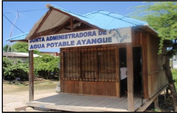
Foto JPG No. 16 Junta de agua potable de Ayangue
