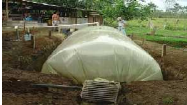
Figura 6.3: Biodigestor tipo Salchicha en funcionamiento, Yucatán-México. Fuente: Los biodigestores
