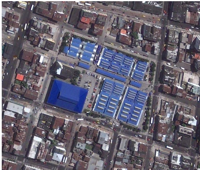
FIGURA # 13: VISTA AEREA DEL MERCADO ARTICULOS VARIOS
