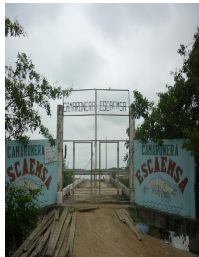
Foto JPG. 2 Puente de Ingreso a la camaronera ESCAEMSA
