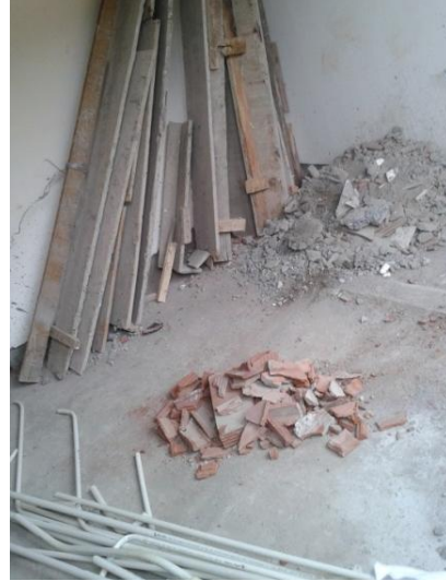
Fotografía 3.9: Materiales clasificados en obra.
