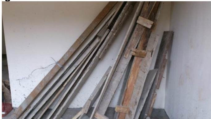
Fotografía 2.1: Madera usada como encofrado en obra.
