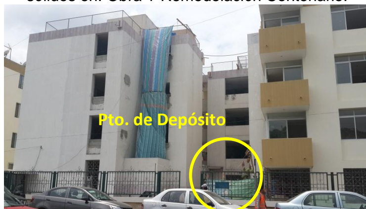
Fotografía 3.3: Punto de depósito de los desechos sólidos en. Obra 1-Remodelación Centenario.
