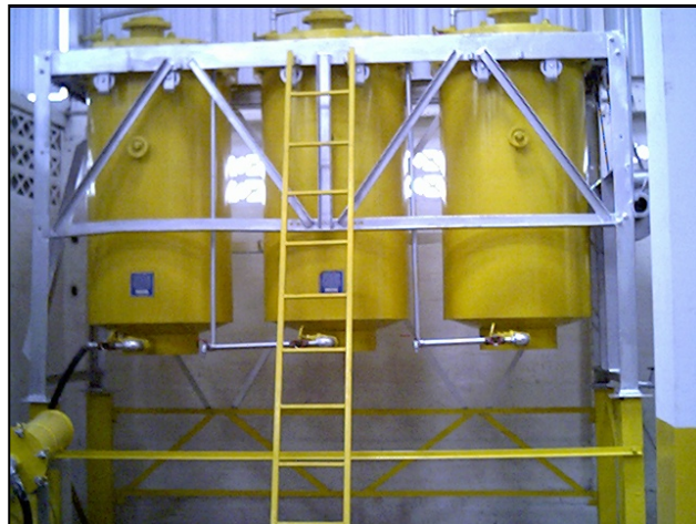
FIGURA 5.13. ESTRUCTURA CON TRES COLUMNAS QUE CONTIENEN TIERRA DE FULLER
