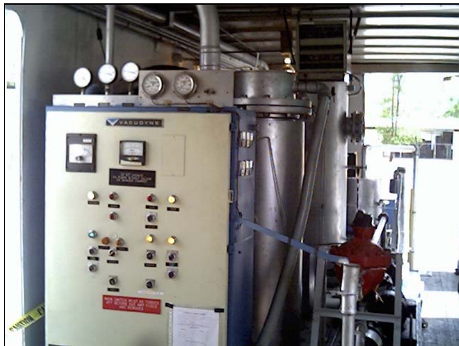
FIGURA B.2 PARTE INTERNA DE UNA MAQUINA DE FILTRADO DE ACEITES DIELECTRICOS
