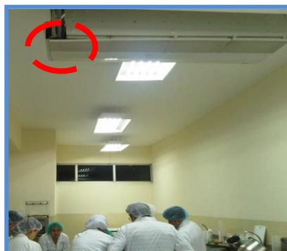
Figura 3.19: Aire Acondicionado del Lab. De I+D en malas condiciones.
