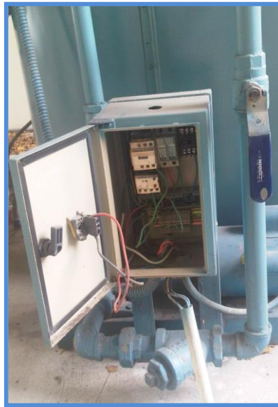
Figura 3.15: Tablero eléctrico del caldero.
