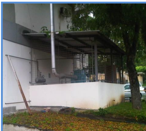
Figura 3.11: Área de Caldero.
