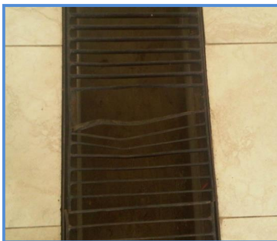
Figura 3.10: Condiciones de Rejillas.
