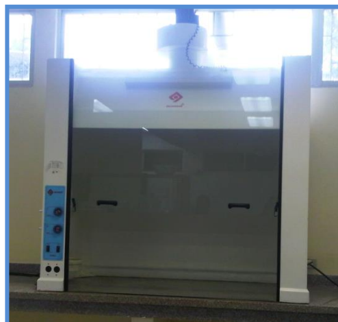
Figura 3.39: Sorbona extractora de gases Fuente: Marcos Olaya Aguilar
