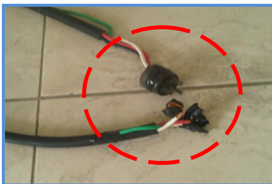
Figura 3.5: Extensiones eléctricas en mal estado Fuente: Marcos Olaya Aguilar.
