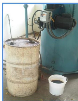
Figura 3.17: Tanques de combustible.
