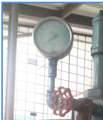
Figura 3.13: Manómetro de caldero.
