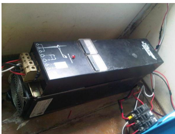
Figura 3.7. Regulador eólico Bornay
