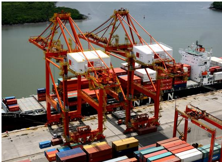
Ilustración 50. Grúa Quay crane (Fuente: Contecon)
