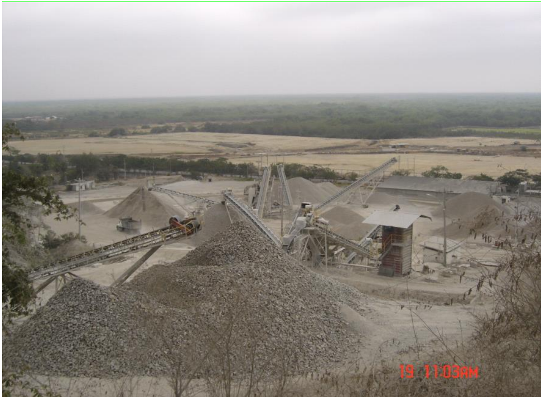
FIGURA 1.3.- Foto de la Planta Industrial de 350 TPH
