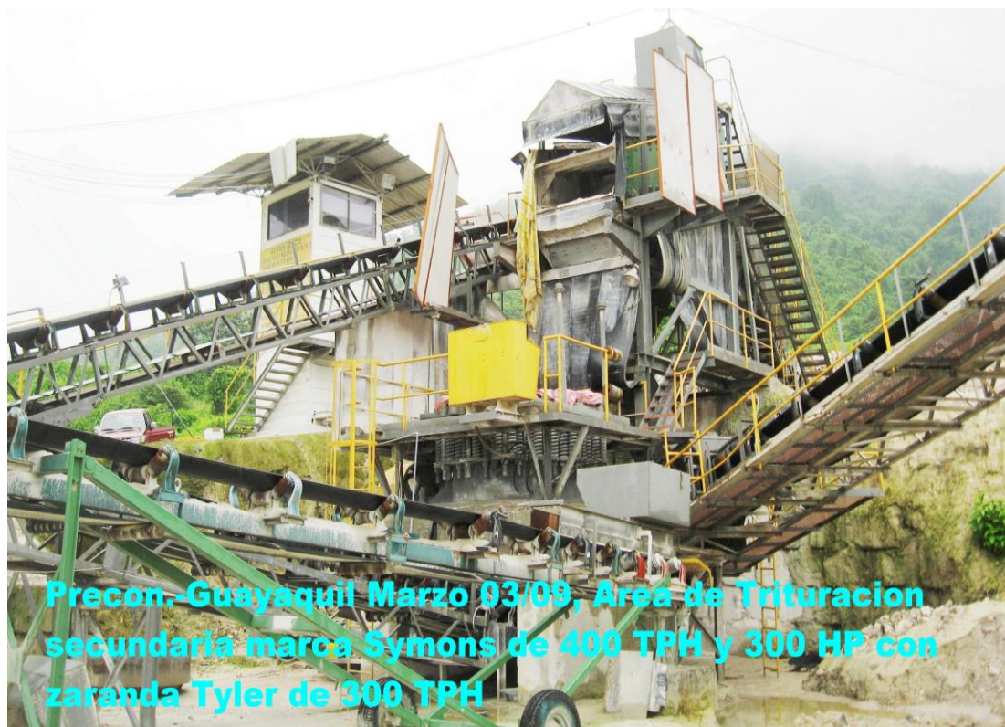
FIGURA 2.7.- Foto de equipos de trituración y separación de sección secundaria.
