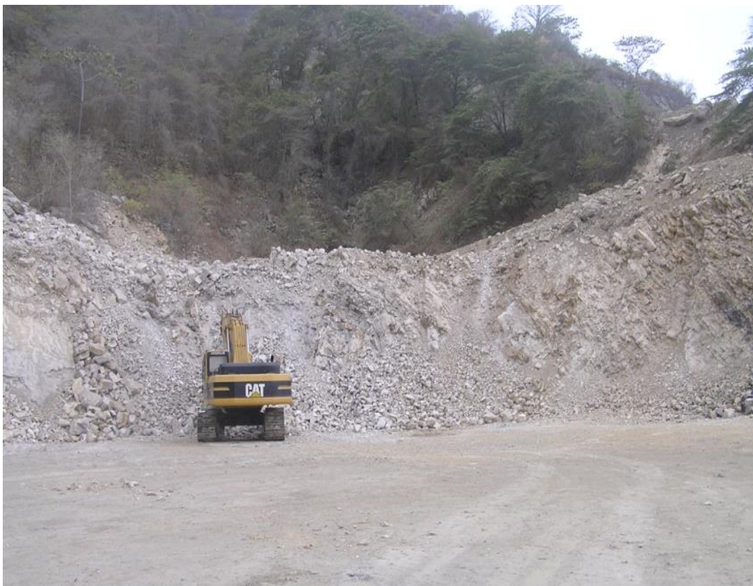
FIGURA 2.3.- Foto de extracción de material ya volado.
