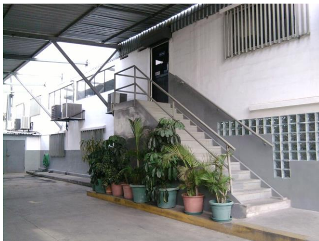
FIGURA 3.19. ESCALERA DEL ÁREA ADMINISTRATIVA
