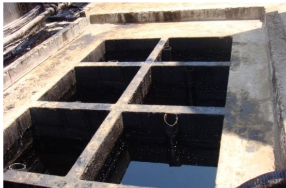
FIGURA 1.4. TRAMPAS DE DECANTACIÓN
