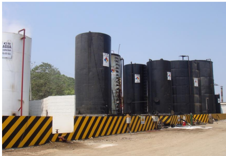
FIGURA 1.1. INSTALACIONES DE LA PLANTA INDUSTRIAL
