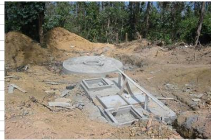
**Tanque septico lixiviados Celica
