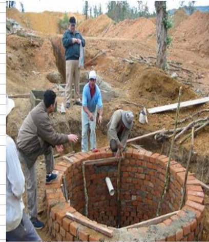
**Tanque septico lixiviados Celica
