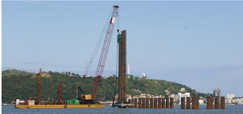
FIGURA 1.2 HINCADO DE PILOTES EN EL TRAMO CENTRAL (1)
