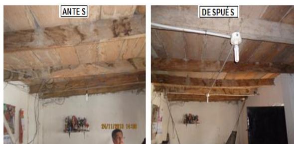
Figura 7. Readecuación eléctrica-Puesta de tuberías
