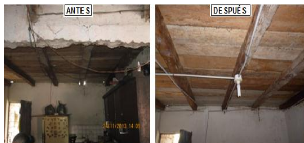
Figura 8. Readecuación eléctrica-Puesta de tuberías cocina
