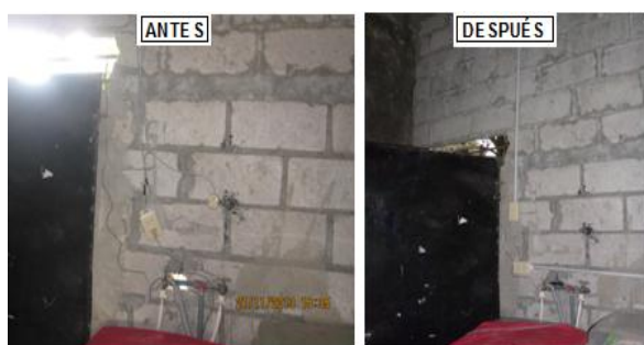
Figura 6. Readecuación eléctrica-Puesta tomacorriente
