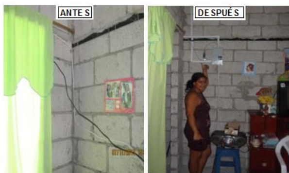
Figura 5. Readecuación eléctrica-Puesta caja de breaker
