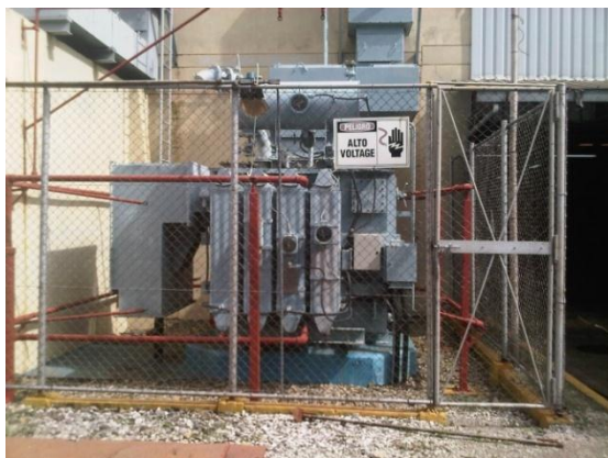
Figura 6.- Transformador de poder auxiliares
