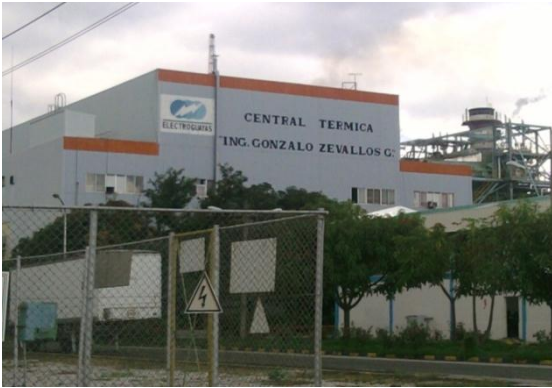
Figura 1.- Central Térmica Ing. Gonzalo
