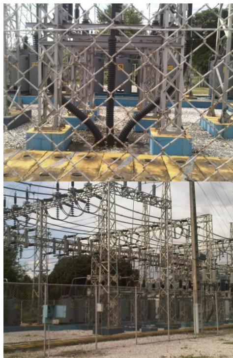
Figura 7.- Patio de maniobras de Subestación
