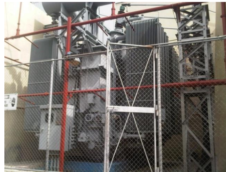
Figura 5.- Transformador de Poder
