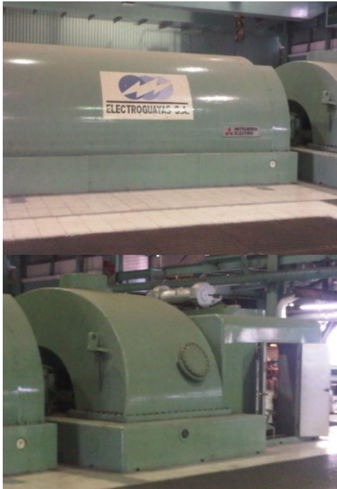
Figura 4.- Acoplamiento Turbina-Generador
