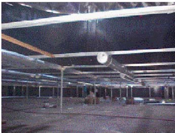
FIGURA 3.8 INSTALACION DE MEMBRANA FLOTANTE
