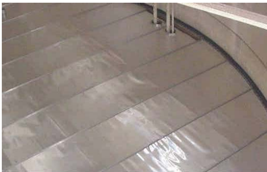
FIGURA 3.9 VISTA DE MEMBRANA FLOTANTE
