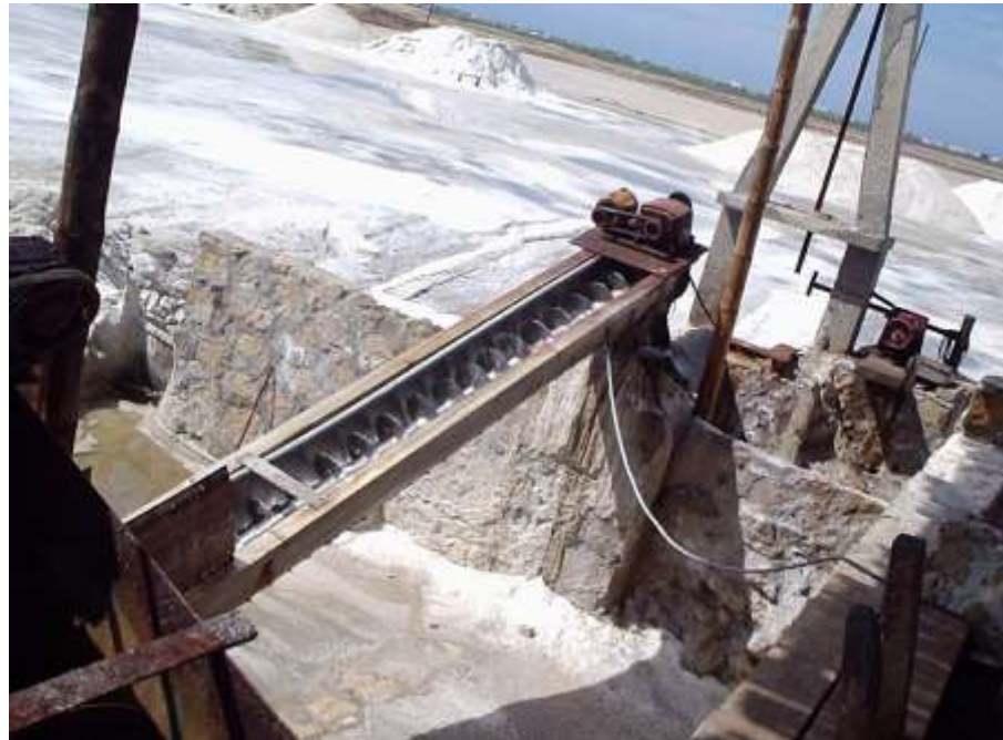
FIGURA 1.11. ACTUAL ESTACIÓN DE LAVADO
