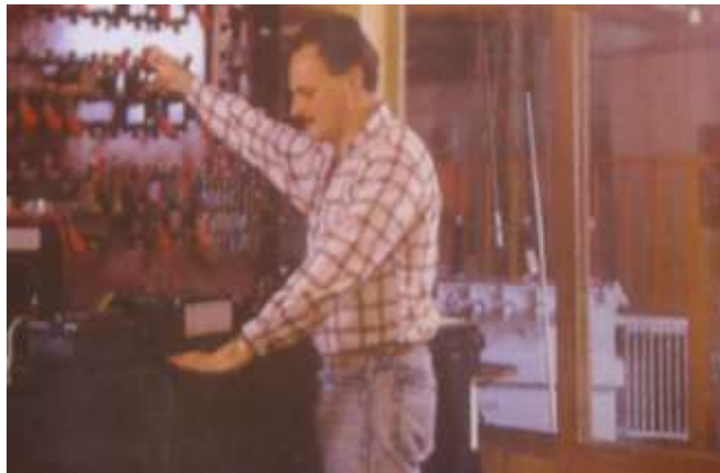
FIGURA 3.2 BANCO DE PRUEBAS DE LOS TRANSFORMADORES
