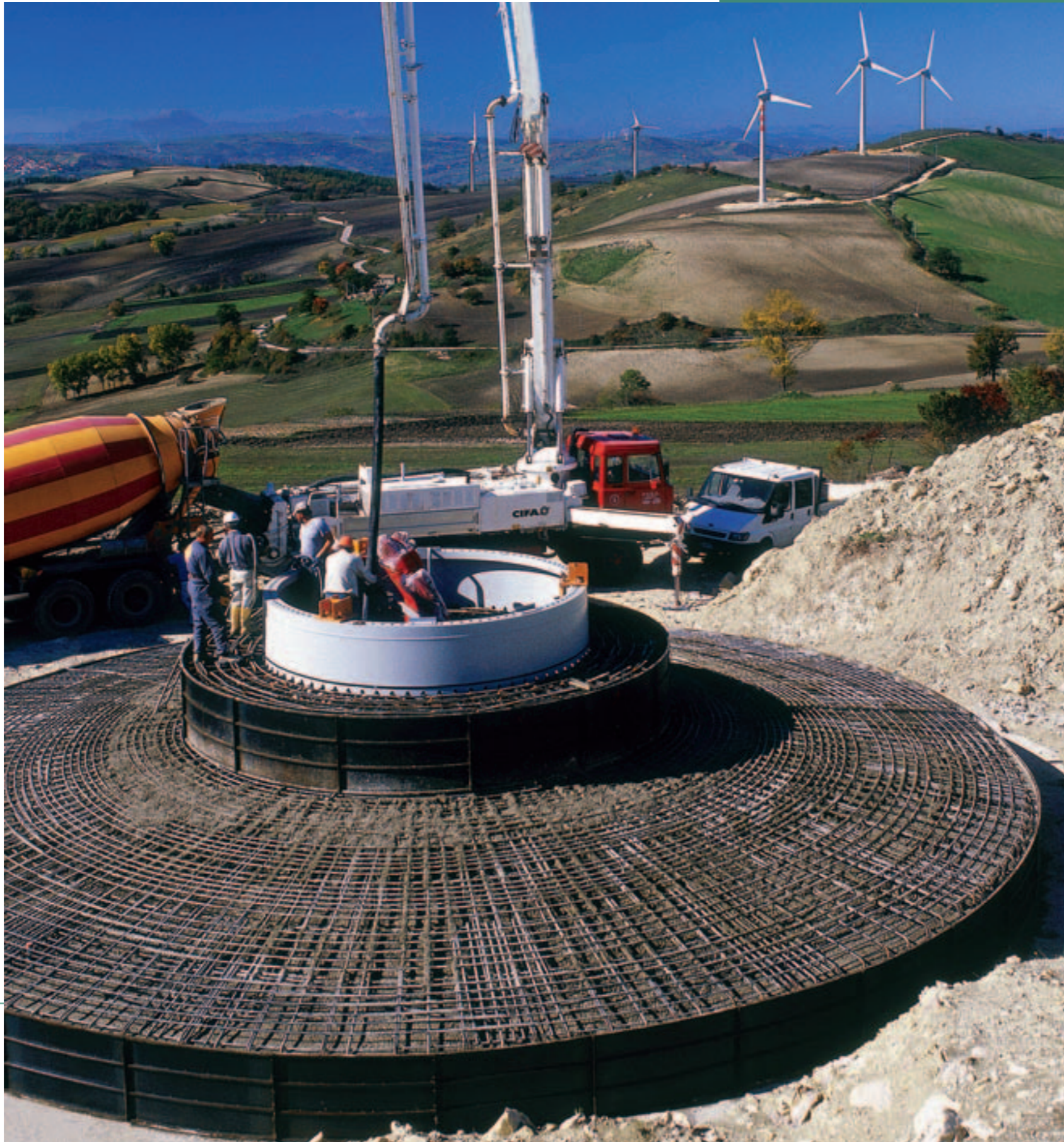
Acero de armadura en una cimentación circular ENERCON con virola para torres de acero tubulares de gran altura
