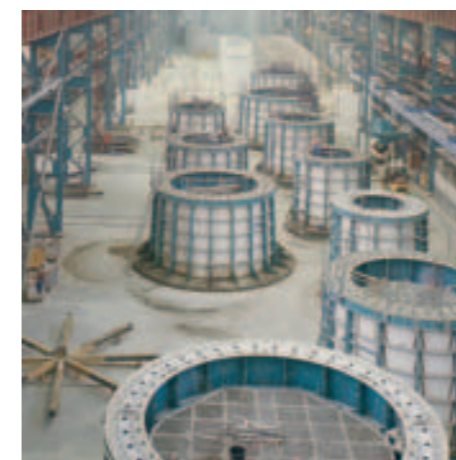
Producción de torres de hormigón prefabricadas ENERCON
