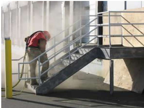
Superficie de escalera durante limpieza
