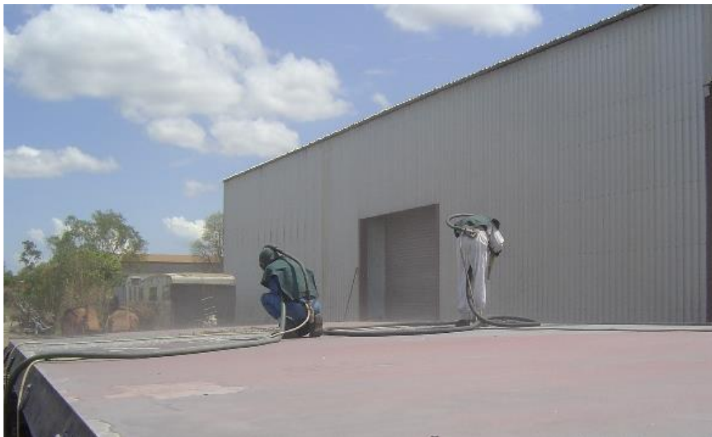
Preparación superficial de planchas de acero
