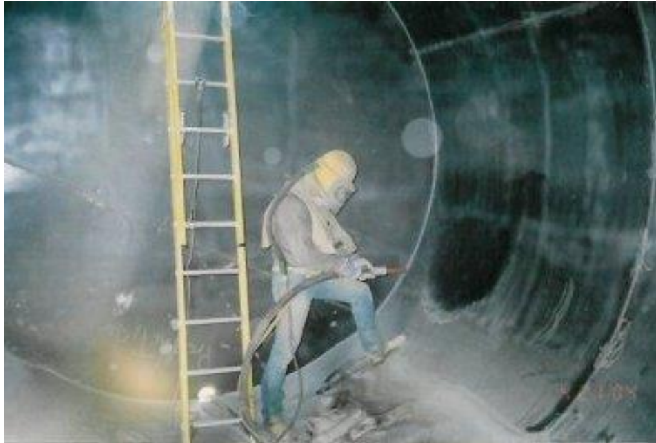
Limpieza en interior de tanques de almacenamiento
