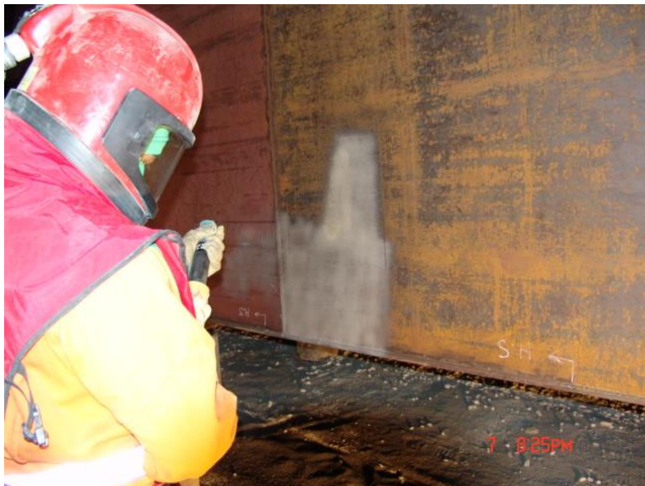
Superficie durante el arenado
