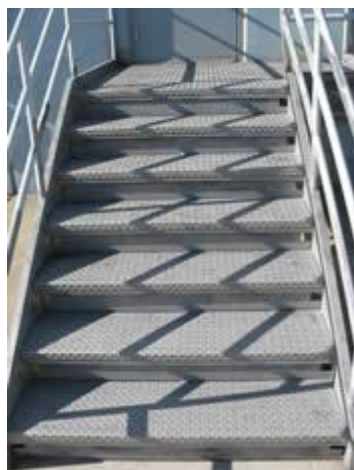
Superficie de escalera después de limpieza
