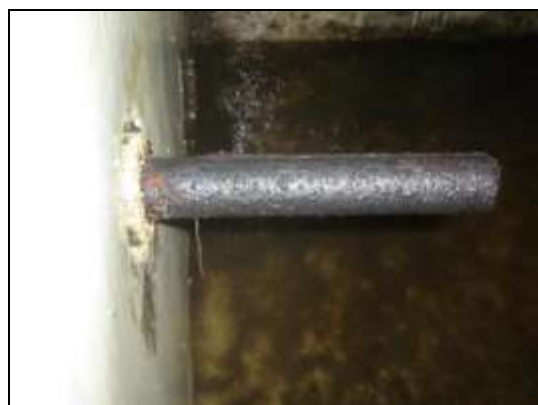
FIGURA 1.8 VISTA DE UN ÁNODO PB-AG-SN DENTRO DEL CONDENSADOR
