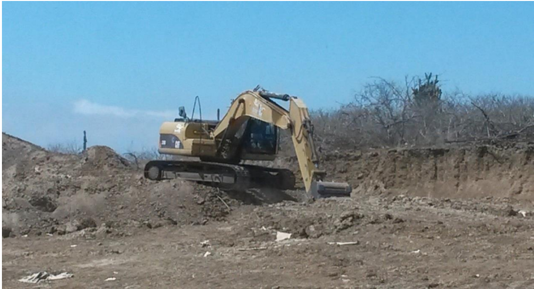
Fotografía 4 Maquinaria de la prefectura explotando material pétreo que se utiliza para cubrir los residuos sólidos.
