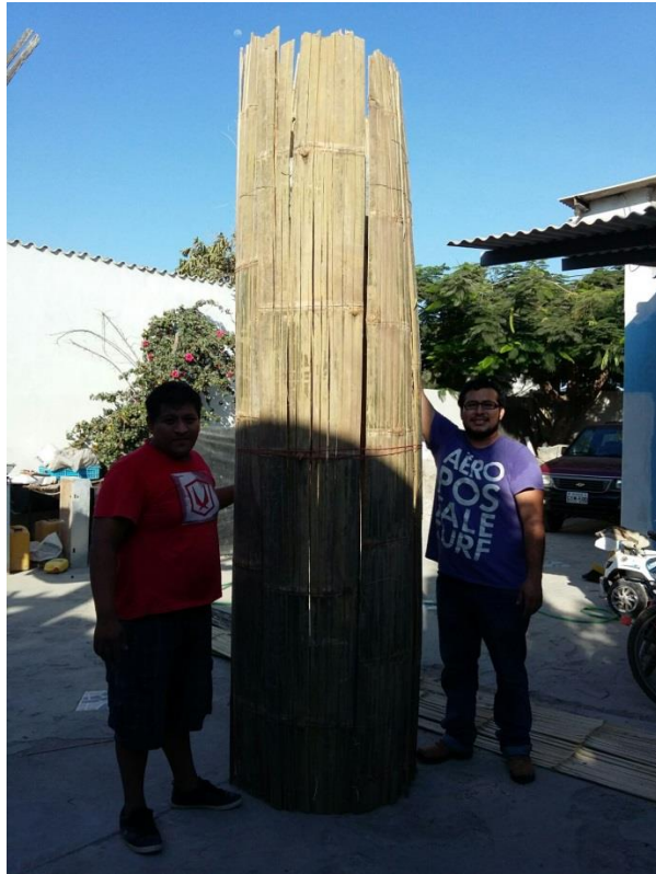
Fotografía 16. Ducto de latilla de caña guadua.
