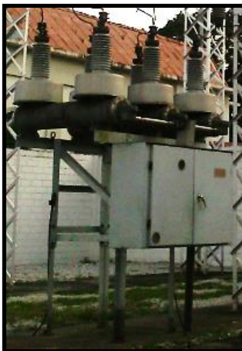
Figura 2.6: Interruptor en gas SF6 de 69 kV.
