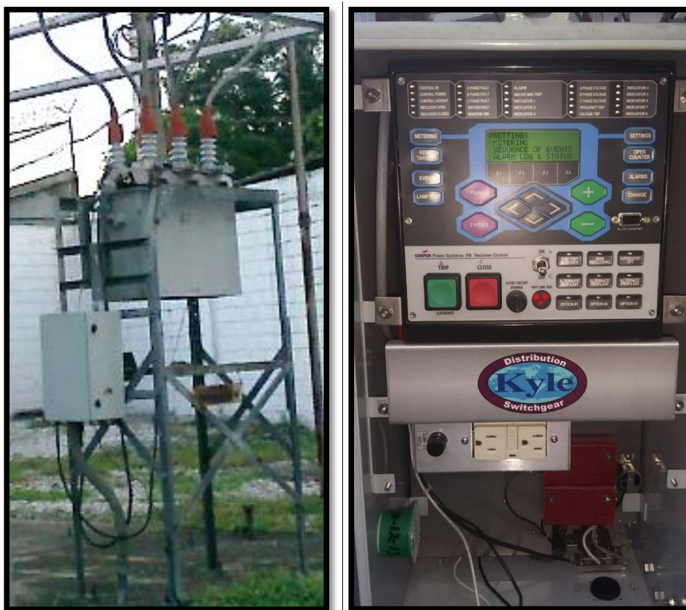
Figura 2.10: Vista del reconector Cooper con su respectivo controlador.
