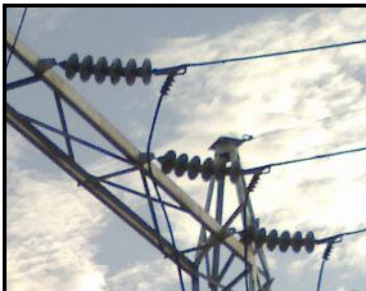
Figura 2.4 Cadena de aisladores de suspensión de 69 kV.
