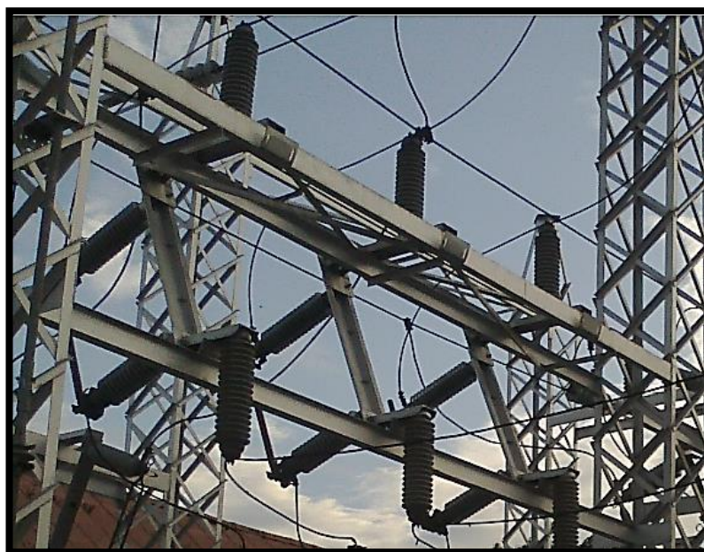
Figura 2.5 Seccionador tripolar de aire con cuchillas para conexión a tierra.
