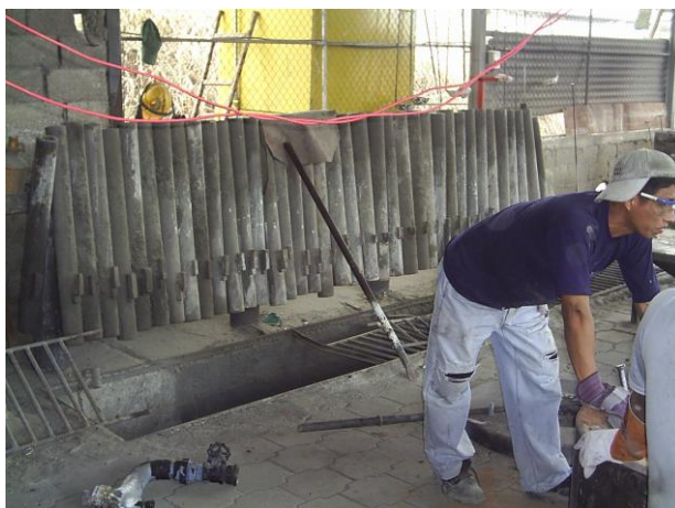
FIGURA 4.3 CANAL DE ENFRIAMIENTO ABIERTO
