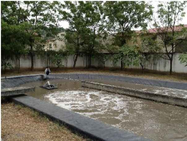
Toma de medidas laguna aireada
