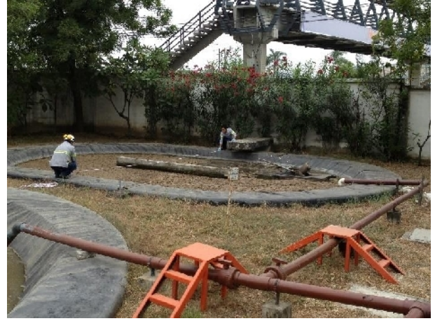
Toma de medidas Digestor de lodos
