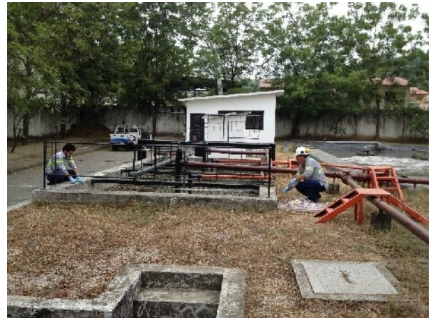
Toma de medidas sedimentador primario
