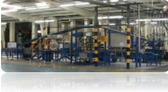
Ilustración 13 Línea de Llenado Cuatro de galón
