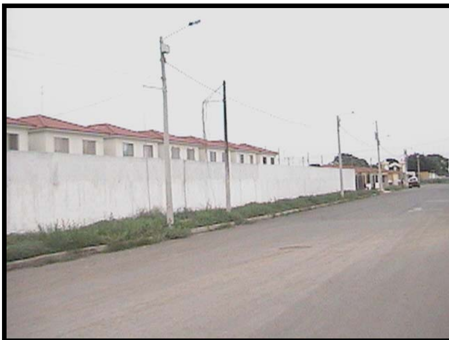
FIG. 3.3 Lindero lateral posterior derecho de la urbanización
