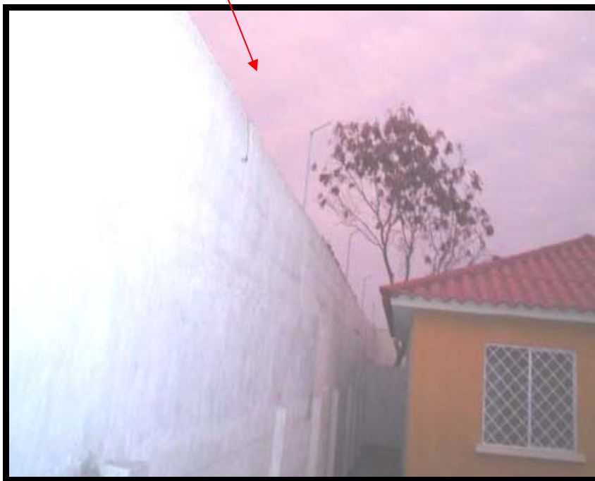
FIG. 3.13 Muro con cerco eléctrico
