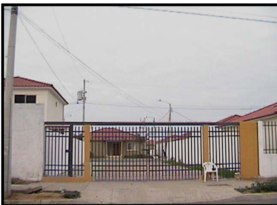
FIG. 3.6 Salida de emergencia, ubicada en el lindero izquierdo de la ciudadela
