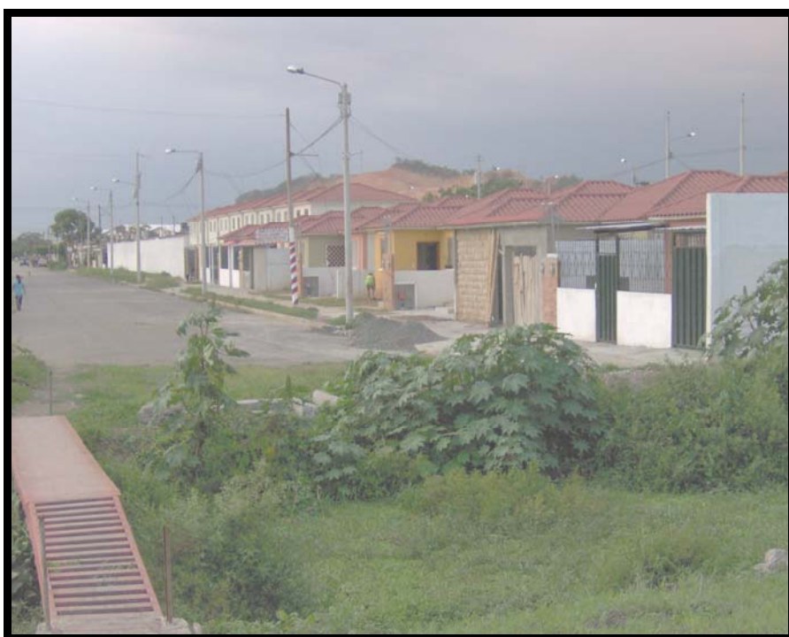
FIG. 3.4 Lindero lateral frontal derecho colindante con la urbanización Punta Panorama
