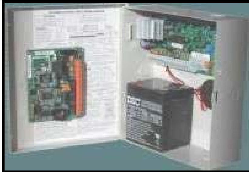
FIG. 4.16 Instalación del MIP en el Panel de Alarmas
