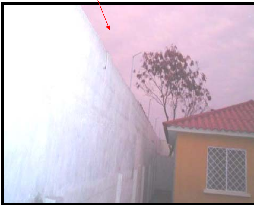
FIG. 3.13 Muro con cerco eléctrico
