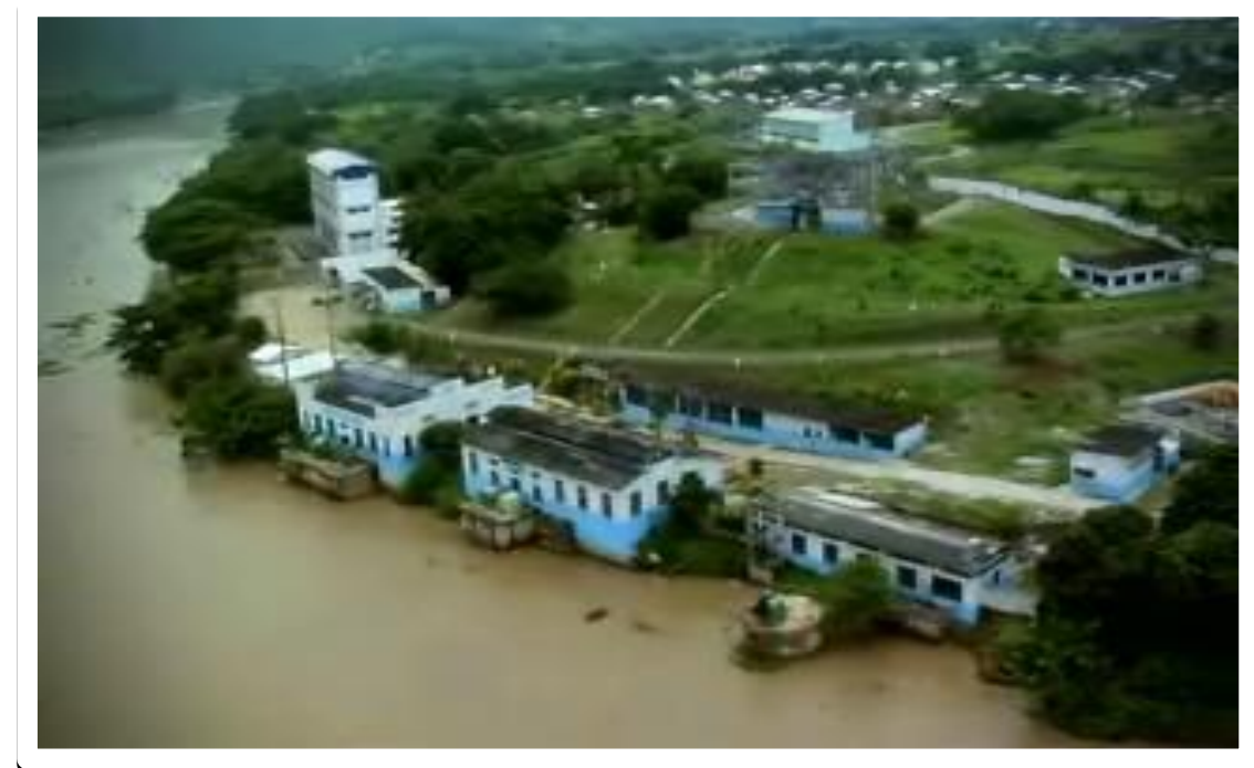
Fotografía 18. Vista panorámica de la estación de Bombeo de la Planta La Toma
