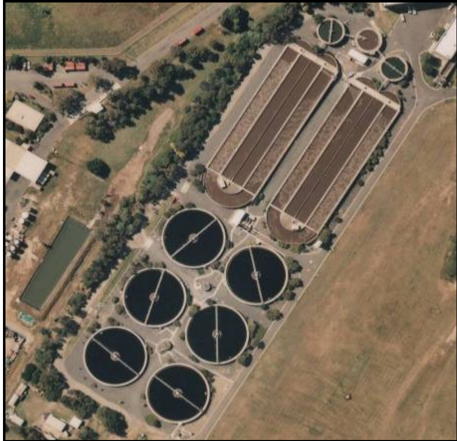
Figura 1.10 Fotografía Aérea de Planta de Tratamiento de Aguas Residuales, Australia.
