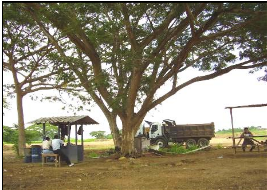
Figura 3.10 Estación de Trabajo para movimiento de tierra del proyecto (109) .
