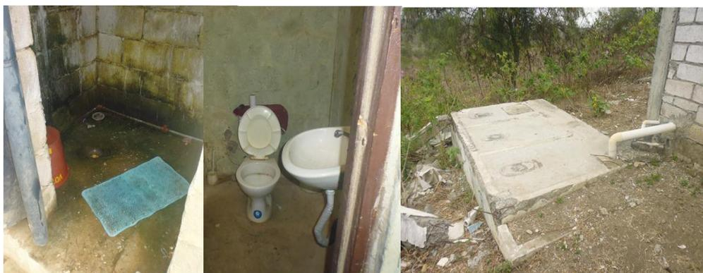
**Fotografía 10.- Aguas servidas son depositadas en tanque séptico.**
