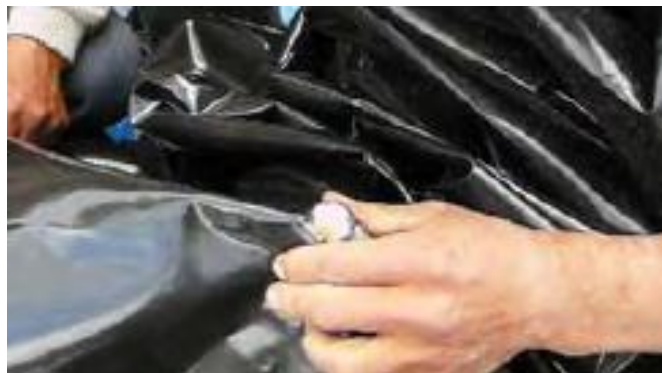
Figura 27. Colocación de toma para salida de biogás
