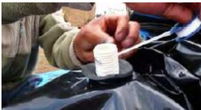
Figura 28. Ajuste de toma para salida de biogás
