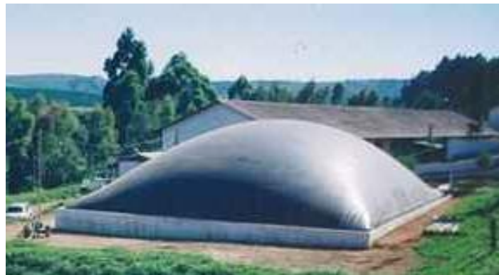
Figura 16. Biodigestor semirrígido
