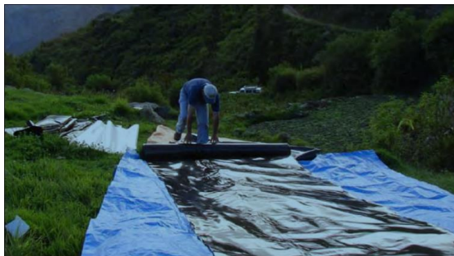
Figura 25. Desenrollando el rollo de polietileno tubular
