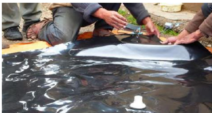
Figura 29. Sellado de los extremos del plástico
