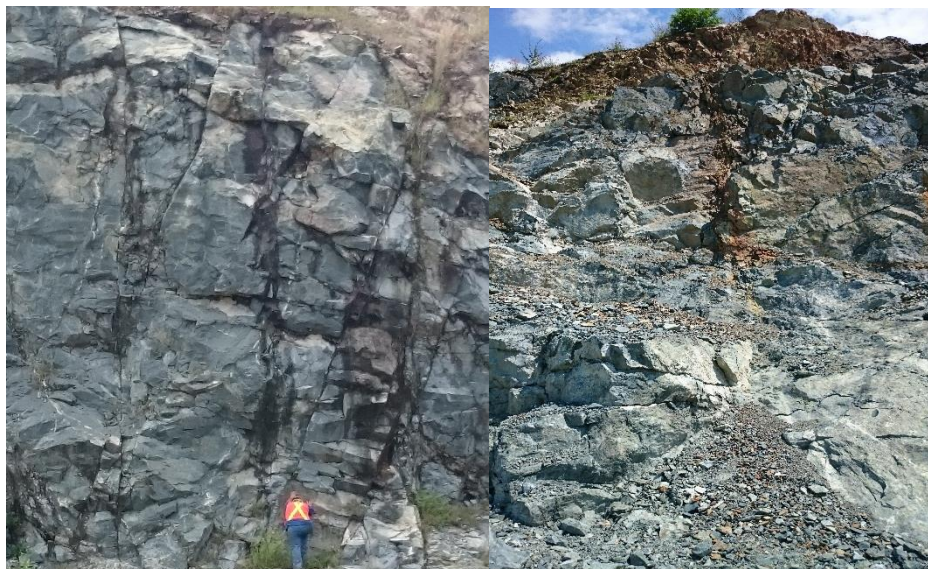
Figura N° 15.- Macizo Rocoso de la cantera
