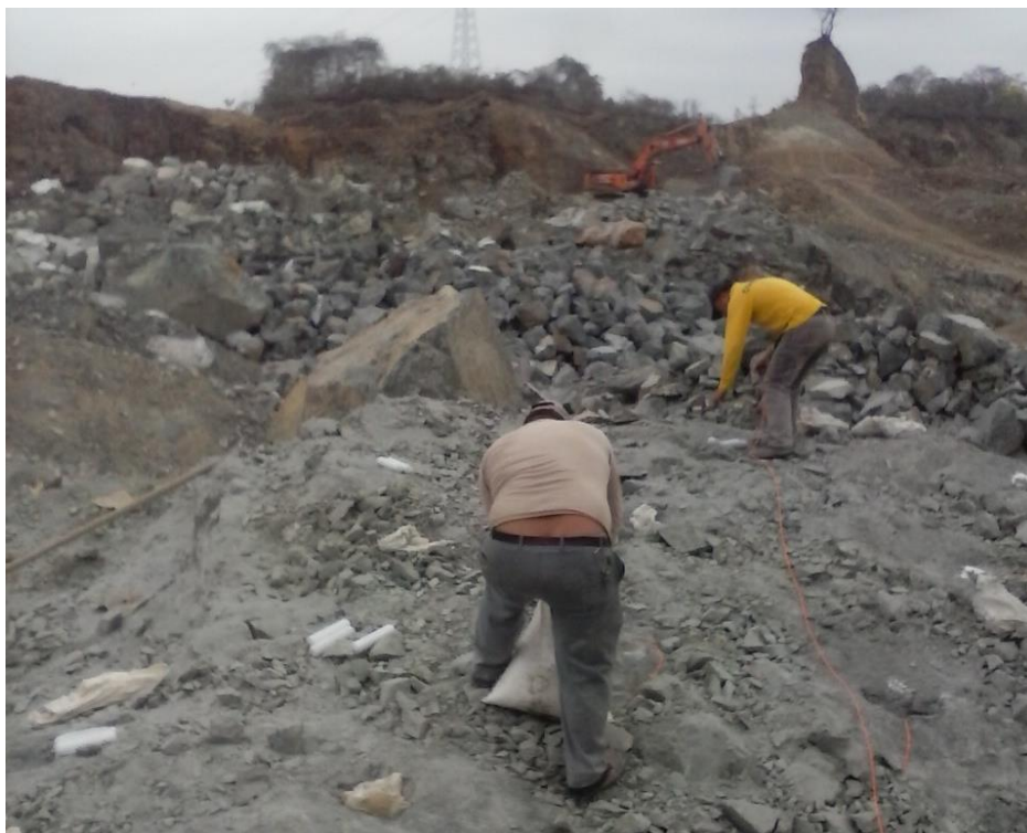
Figura N° 44.- Trabajos de cebado y carga de barrenos
