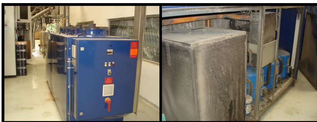
FIGURA 2.17. CHILLER KLC 63 - SISTEMA DE ENFRIAMIENTO
