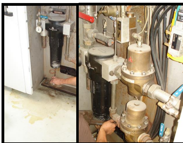
FIGURA 2.9. APERTURA DEL GRIFO DE DESCARGA Y REMOCIÓN DEL FILTRO DE ALTA PRESIÓN
