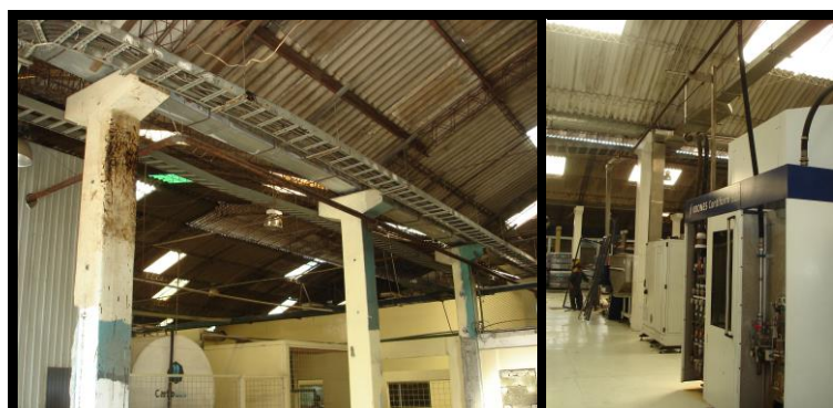
FIGURA 2.10. TUBERÍA DE AIRE COMPRIMIDO DE ALTA PRESIÓN
