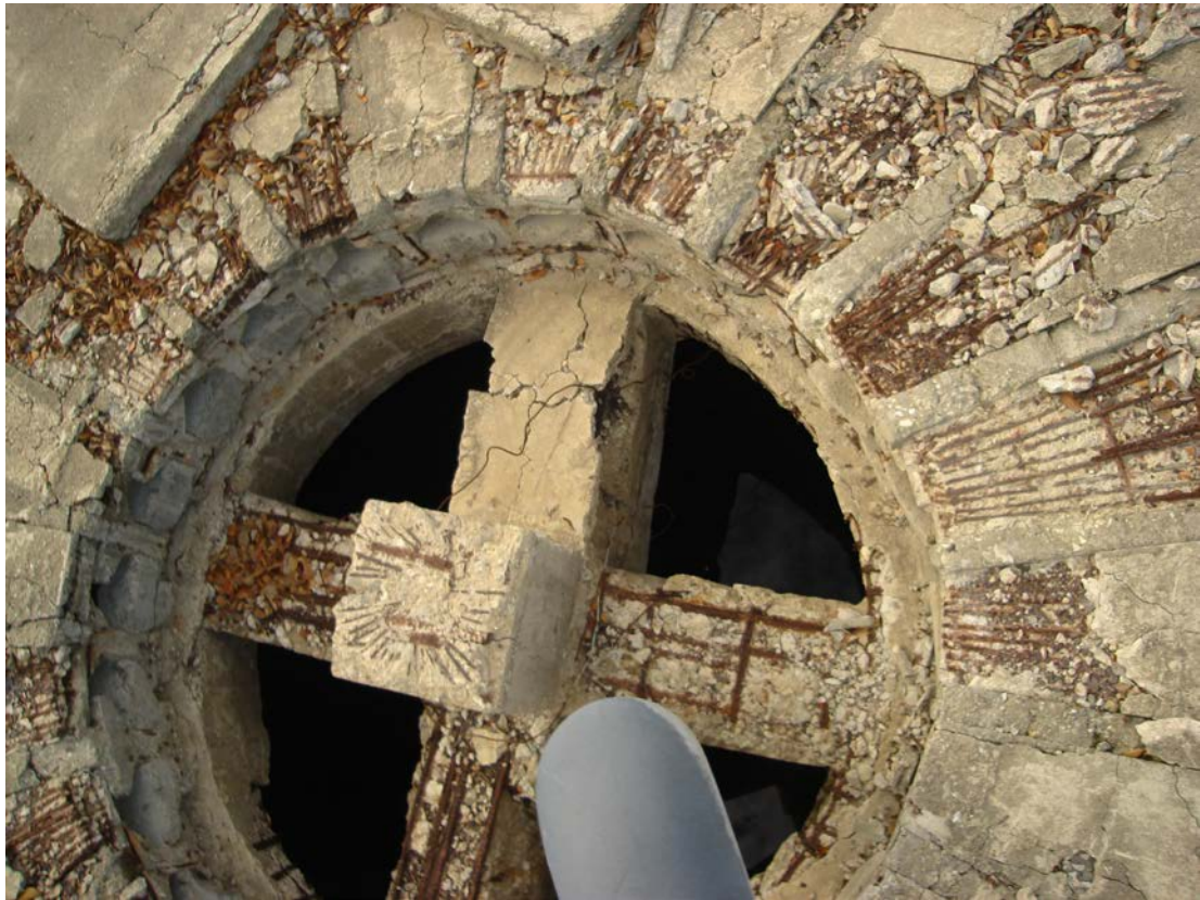
FIGURA 4.2 TAPA TANQUES CILÍNDRICOS DE ALMACENAMIENTO
