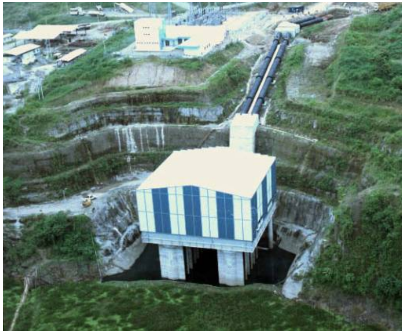
Gráfico 1.6 Estación de Bombeo Severino
