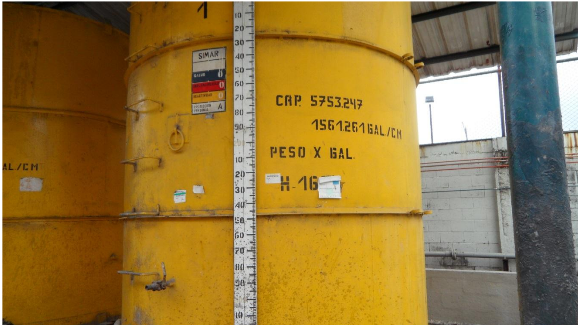
Figura 1.1. Tanques de almacenamiento temporal del látex en PINTEC.
