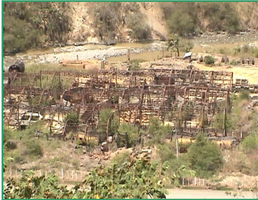
Foto 6: Instalaciones de la planta antiguas.
