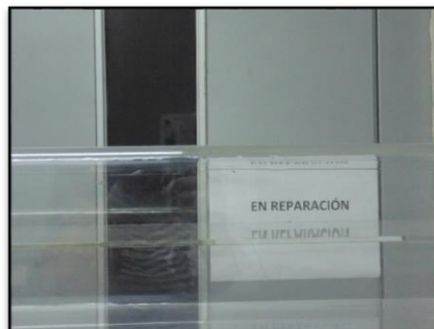
Figura 9: Ascensor (planta alta)
