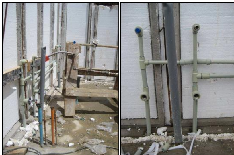
Figura 6.24 Instalación del sistema eléctrico y sanitario.
