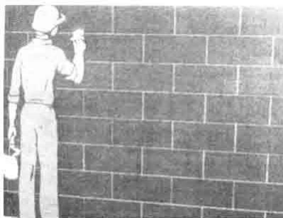
Figura 6.11 Curado de las juntas de mampostería con brocha. Fuente: (Instituto Costaricense del Cemento y del Concreto, 2007)
