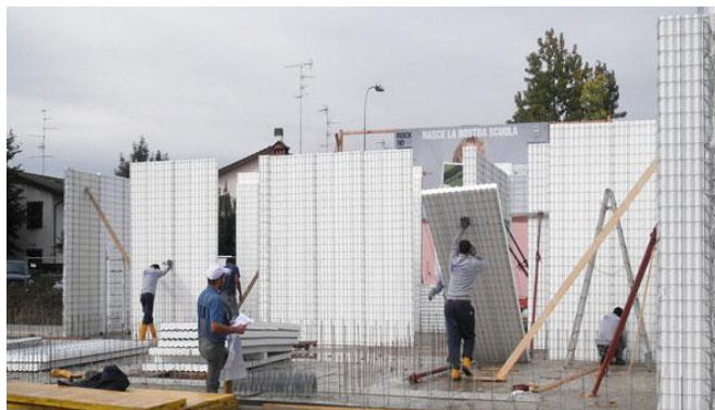
Figura 6.16 Aplomada y fijación de los muros Fuente: (La revista, 2015)
