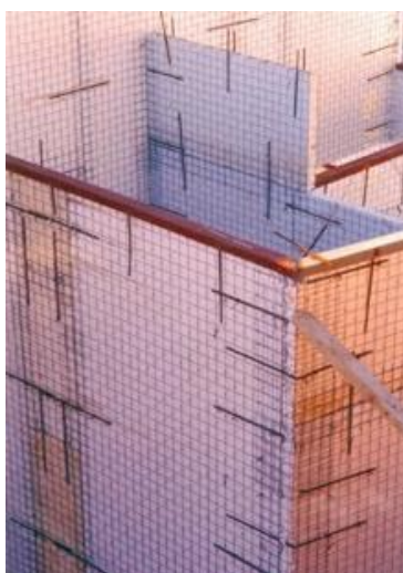
Figura 6.17 Fijación de varillas angulares en las esquinas de los muros Fuente: (Gerry Bastidas, 2105)
