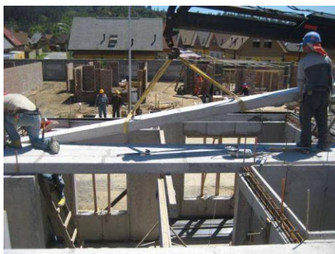
Figura 6.28 Colocación de losa en la vivienda. Fuente: (Cementos BIO BIO, 2002)
