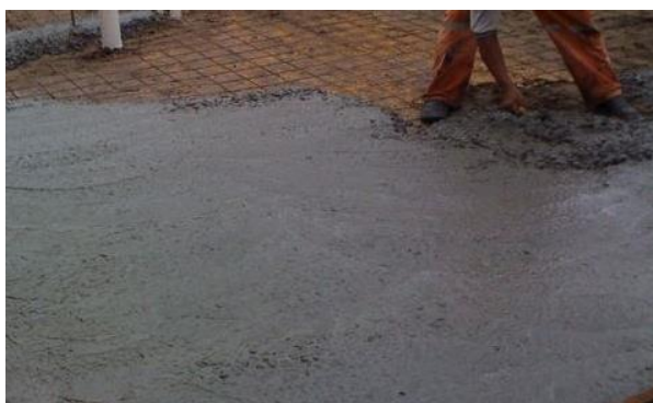
Figura 6.13 Fundición del contrapiso Fuente: (industrias Génesis y construcciones)
