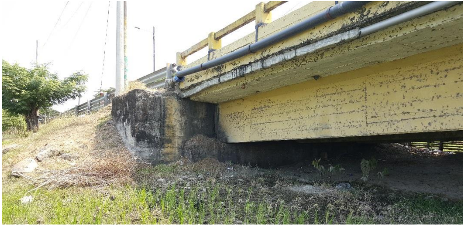
Fotografía 4.9: Estribo E1 del puente de Tarifa. Fuente: Autores.
