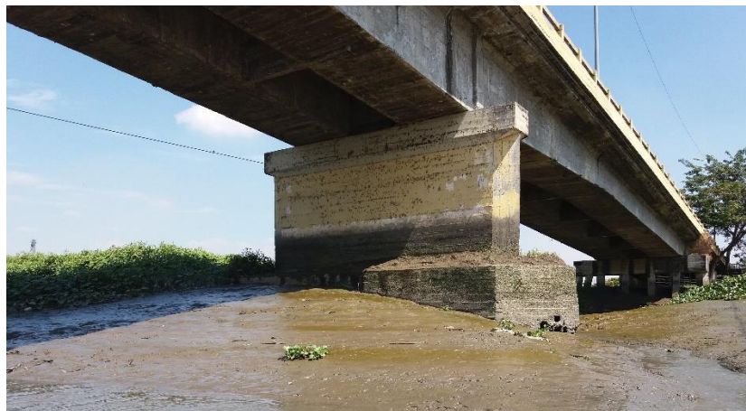
Fotografía 4.12: Pila P2 del puente de Tarifa. Fuente: Autores.
