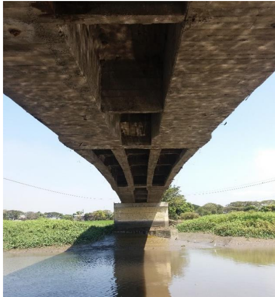
Fotografía 4.6: Vigas y diafragmas del puente de Tarifa en el tramo # 3. Fuente: Autores.
