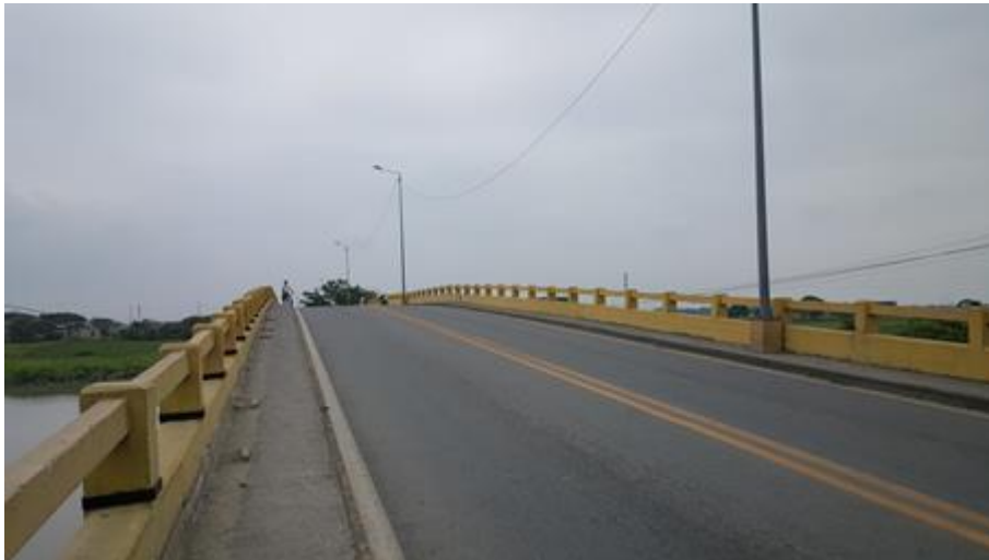
Fotografía 4.2: Tablero del Puente de Tarifa. Fuente: Autores.
