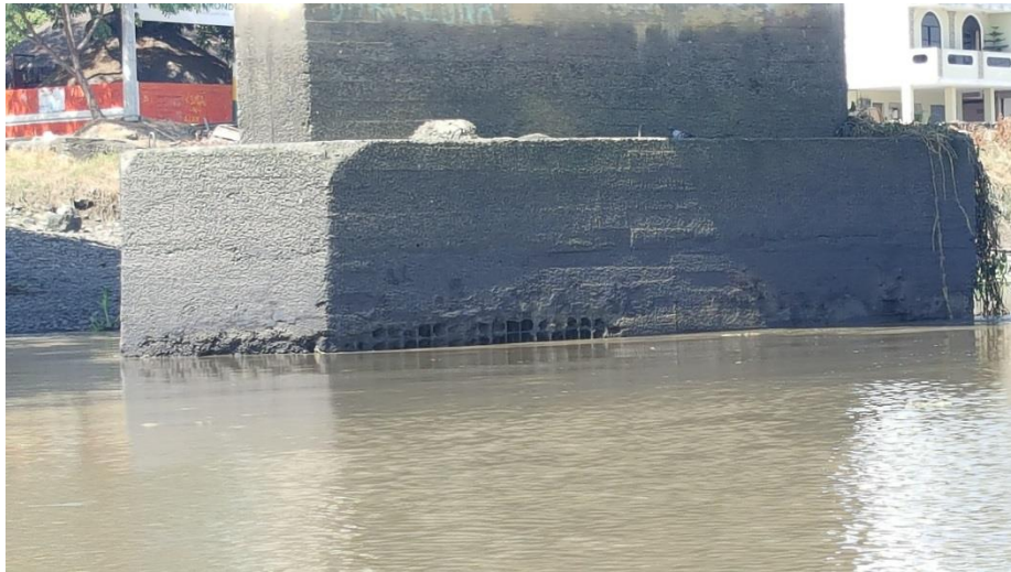
Fotografía 4.34: Estado actual, cimentación de la pila P3.
