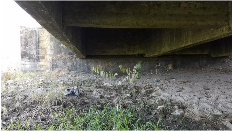
Fotografía 4.3: Vigas y diafragmas del puente de Tarifa en el tramo # 1. Fuente: Autores.
