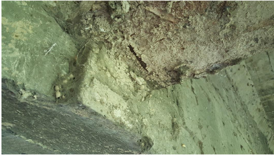
Fotografía 4.25: Estado actual, diafragmas del tramo 1. Fuente: Autores.
