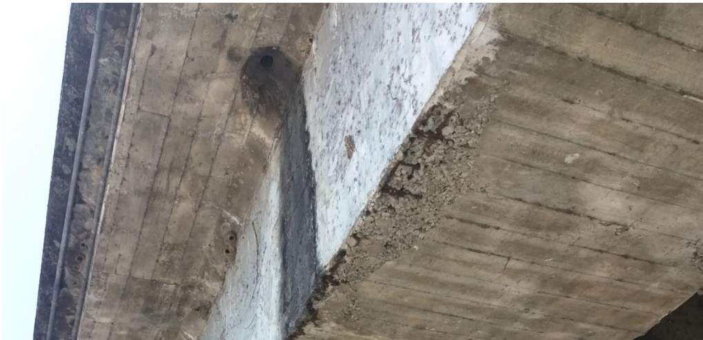
Fotografía 4.18: Estado actual, vigas cajón del tramo 4.
