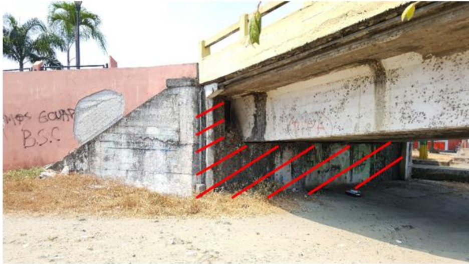
Figura 5.9: Área de aplicación de rehabilitación en el estribo 2. Fuente: Autores.
