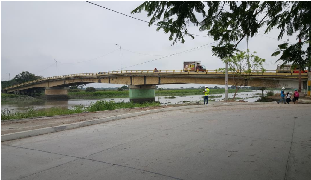
Fotografía 4.1: Vista general del puente de Tarifa. Fuente: Autores.
