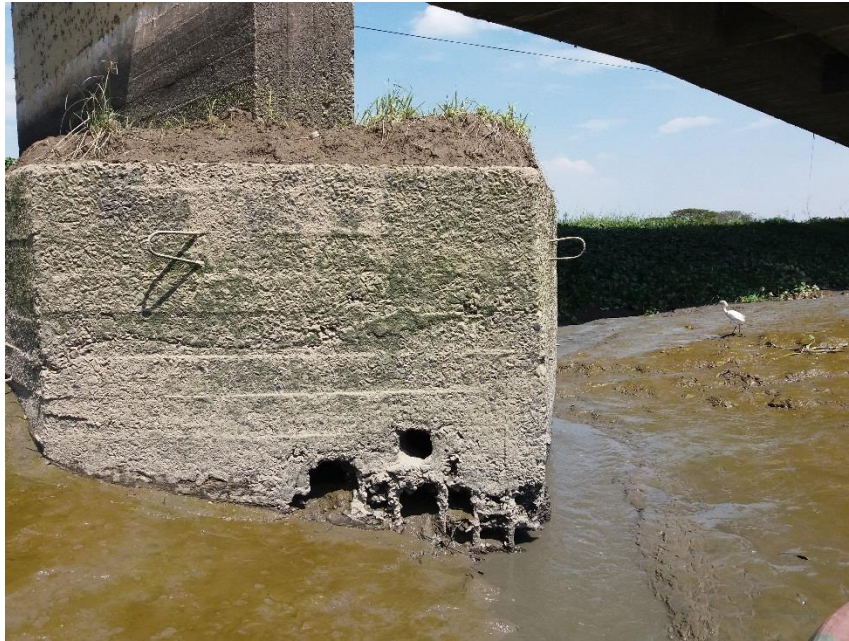
Fotografía 4.35: Estado actual, cimentación de la pila P2. Fuente: Autores.
