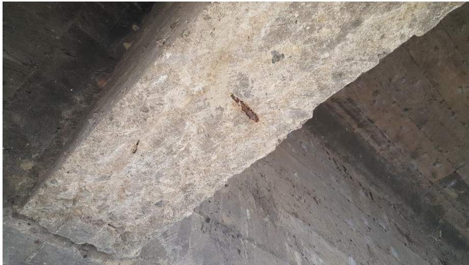
Fotografía 4.26: Estado actual, diafragmas del tramo 4. Fuente: Autores.
