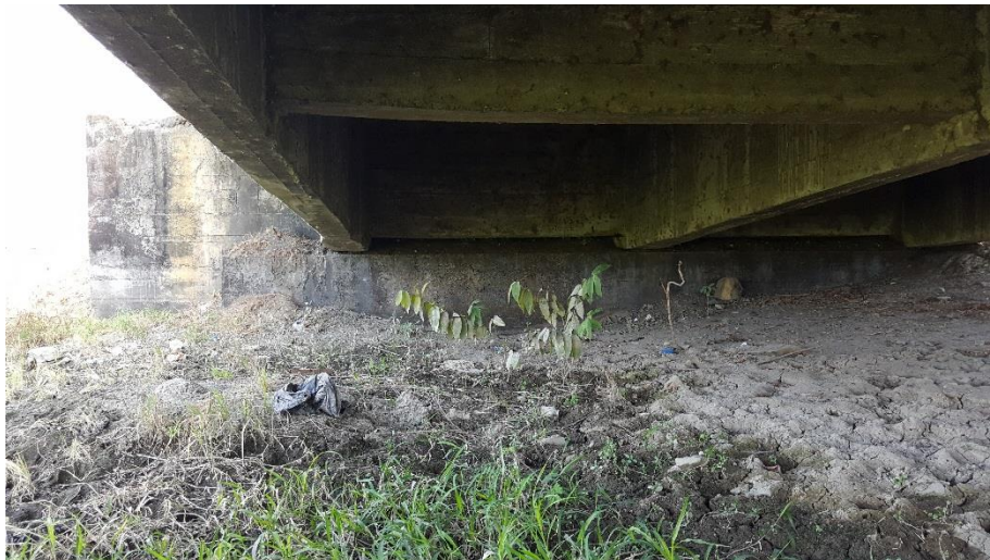
Fotografía 4.24: Estado actual, vigas de hormigón armado del tramo 1. Fuente: Autores.
