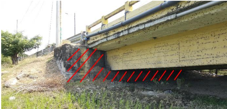
Figura 5.8: Área de aplicación de rehabilitación en el estribo 1. Fuente: Autores.
