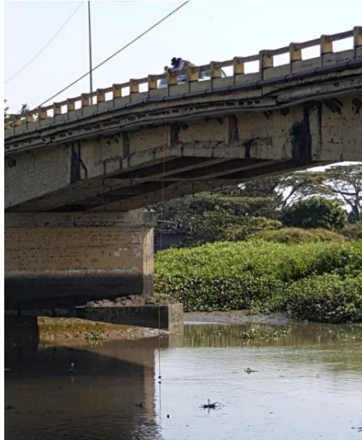
Fotografía 4.8: Medición del galibo del puente de Tarifa, Junio 2016. Fuente: Autores.
