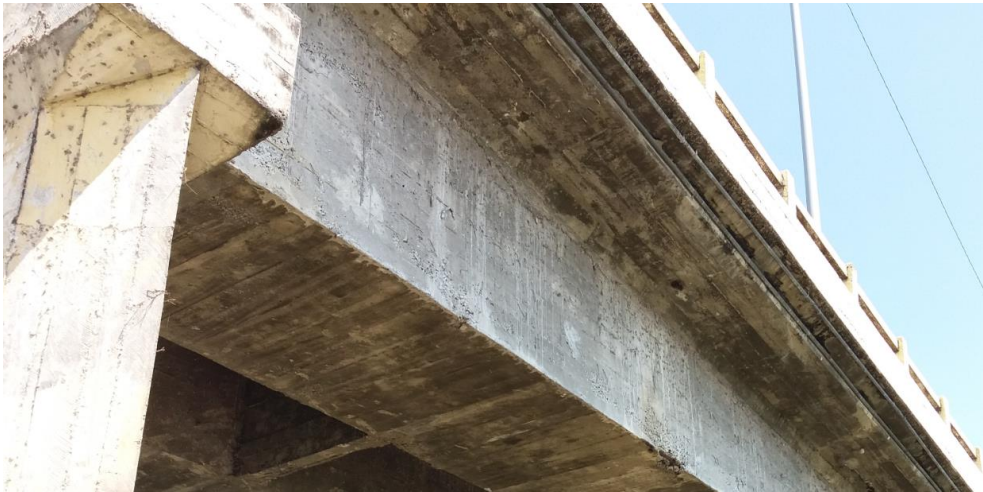
Fotografía 4.20: Estado actual, vigas cajón del tramo 2. Fuente: Autores.
