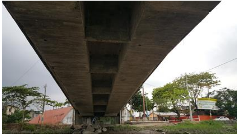
Fotografía 4.5: Vigas y diafragmas del puente de Tarifa en el tramo # 4. Fuente: Autores.
