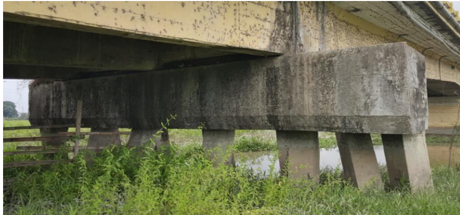
Fotografía 4.11: Pila P1 y pilotes del puente de Tarifa. Fuente: Autores.
