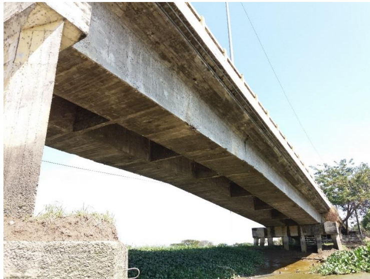
Fotografía 4.4: Vigas y diafragmas del puente de Tarifa en el tramo # 2. Fuente: Autores.
