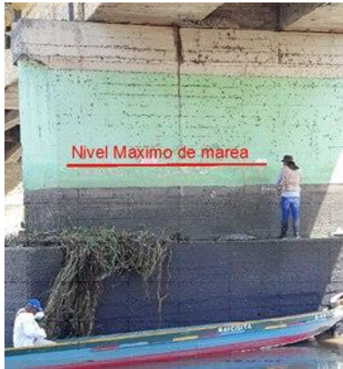
Fotografía 2.1: Nivel máximo de marea en puente actual. Fuente: Autores.
