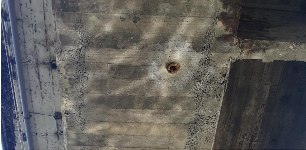
Fotografía 4.19: Estado actual, vigas cajón del tramo 3. Fuente: Autores.
