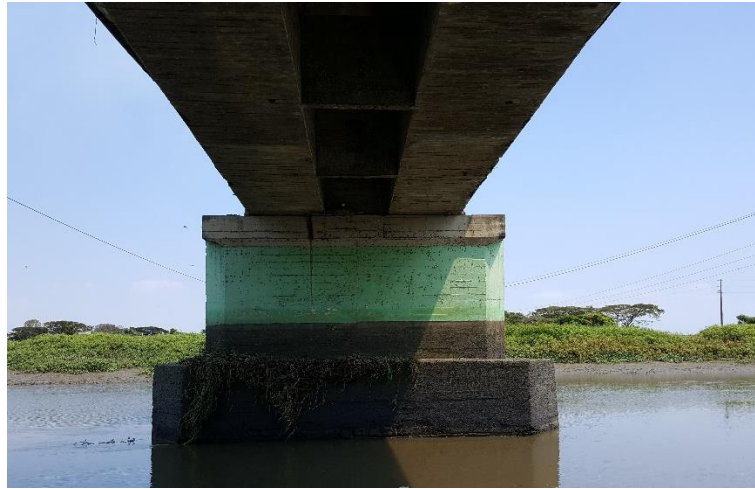
Fotografía 4.13: Pila P3 del puente de Tarifa. Fuente: Autores.
