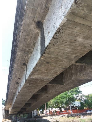
Figura 5.5: Área de aplicación de rehabilitación en vigas del tramo 4. Fuente: Autores.
