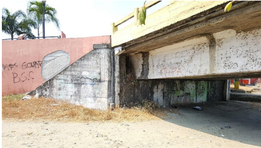
Fotografía 4.10: Estribo E2 del puente de Tarifa. Fuente: Autores.
