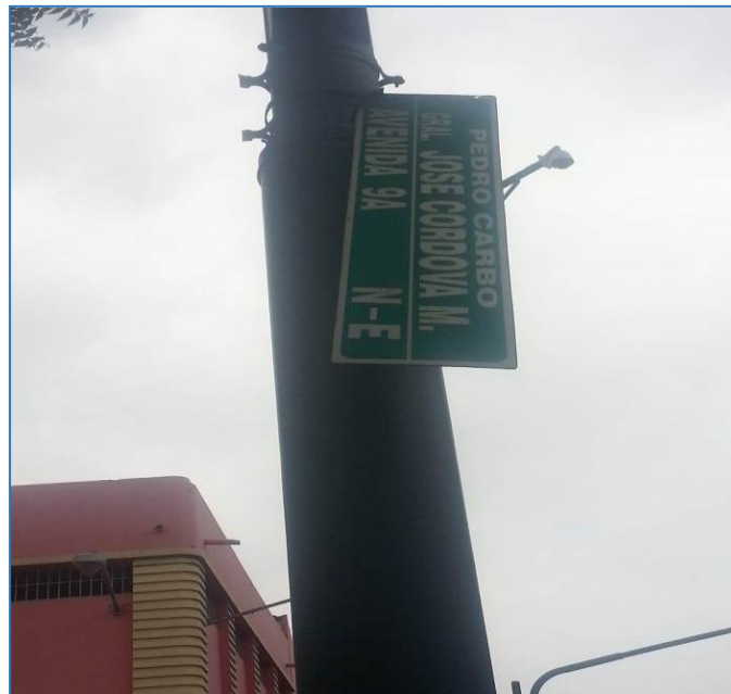
Fotografía 16 Calle Loja – Señalética en mal estado
